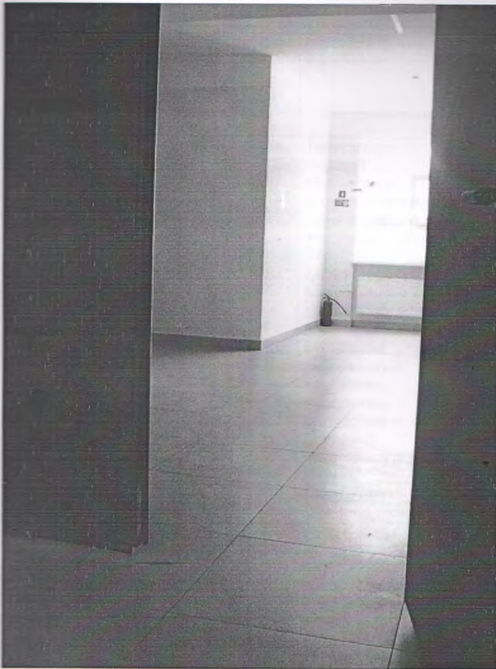
п.3.3. (Двери на 1,2,3 этаже) правое крыло – фото № 45б
