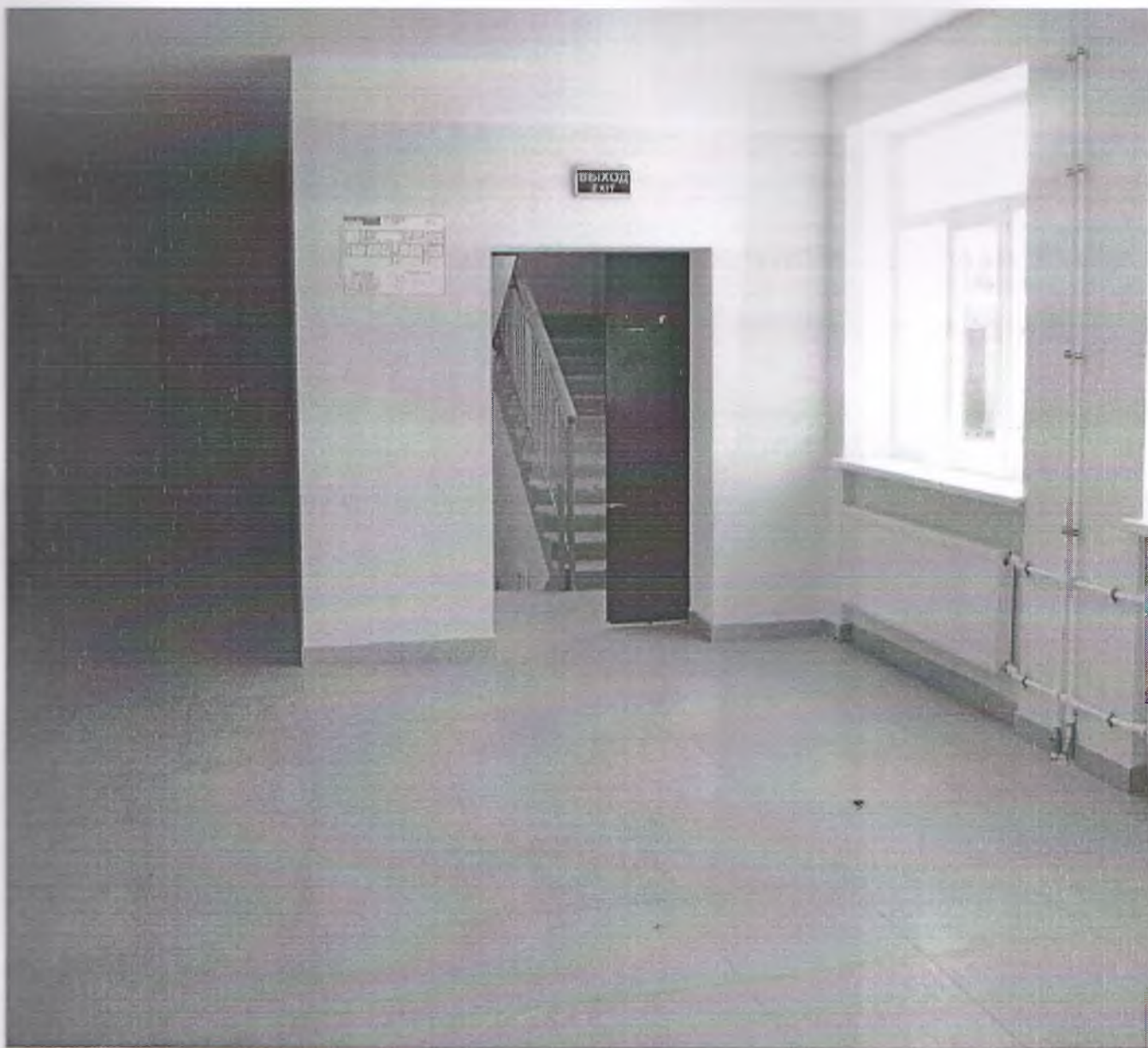
п.3.3. (Двери на 1,2,3 этаже) левое крыло – фото № 45а
